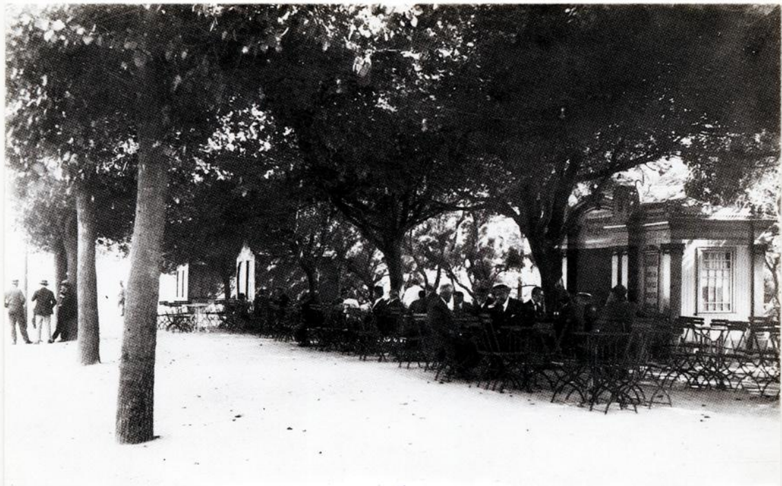
146 - PORTO - (Foz do Douro) - Avenida Frazil (Pavilhões)
