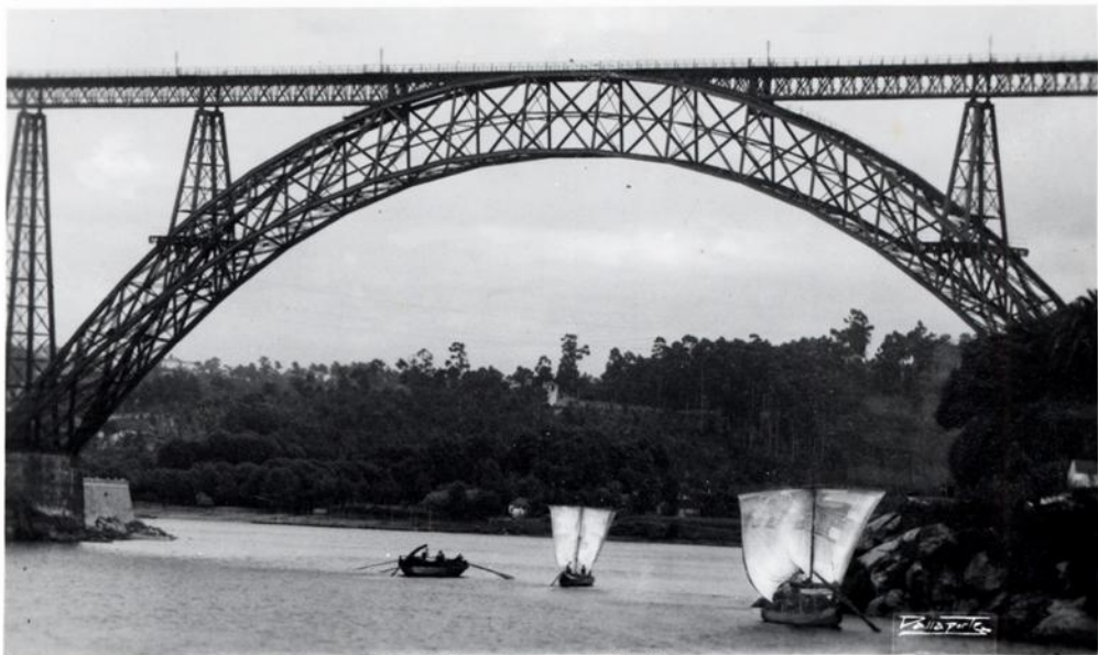
Ponte D. Maria Pia e aspecto do Rio Douro 105 PORTO (Oporto) D. Maria Pia bridge and aspect of the River Douro Pont D. Maria Pia et une aspect de la Rivière Douro
